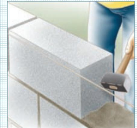
Continuez les rangs comme le premier en posant les éléments «piéd-sur-joint», c'est-à-dire en faisant reposer chaque élément du rang supérieur à cheval sur deux éléments du rang inférieur.
